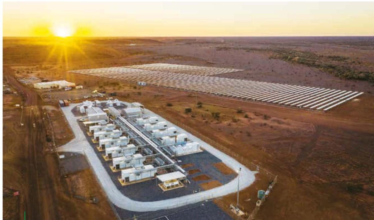
EDL 位於澳洲 Agnew 金礦場的混合式可再生能源微電網，成功引證開採業可以增加使用並儲存可再生能源。
