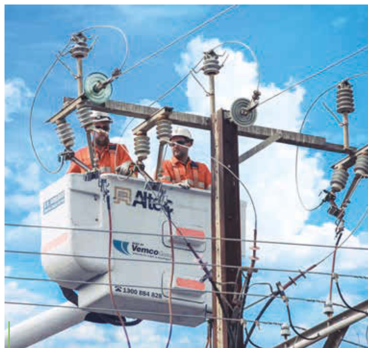
SAPN 的技術人員進行架空電纜工程，確保供電安全。
