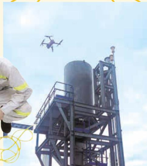
港燈員工採用無人機協助檢驗燃煤發電機組及燃氣聯合循環發電機組的消音器。
