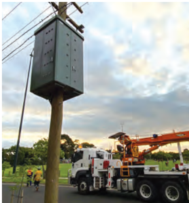
United Energy 正進行一項名為 Bayside Battery Project 的桿裝式電池試驗計劃，以應對高峰時段的電力需求。
