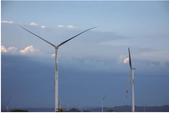
山西平定100兆瓦風電項目
