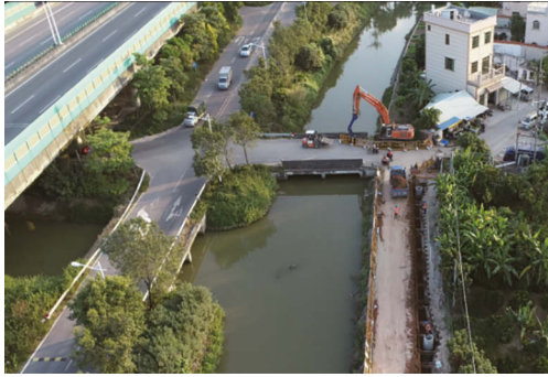
中山市水體綜合整治工程
