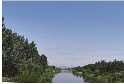
河北省唐山市豐南、南堡等工業區供水工程PPP項目
