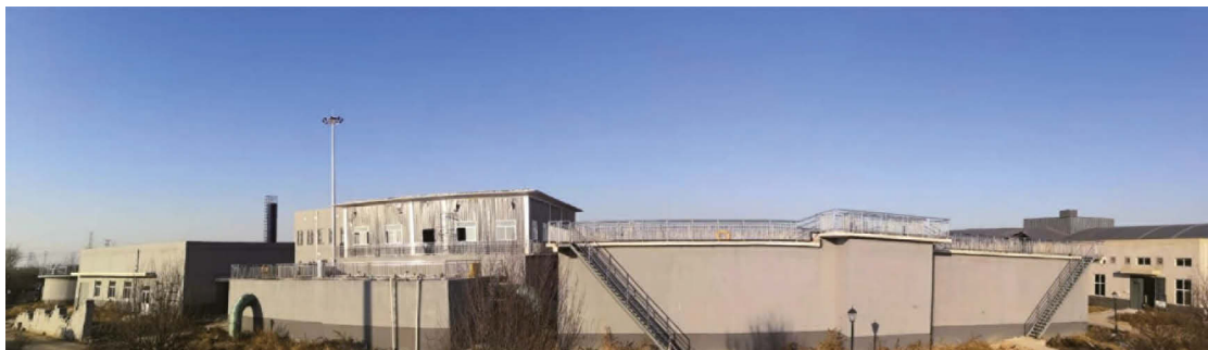
定州市鐵西再生水廠委託運營項目
