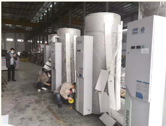
工人趕工安裝調試供暖設備
