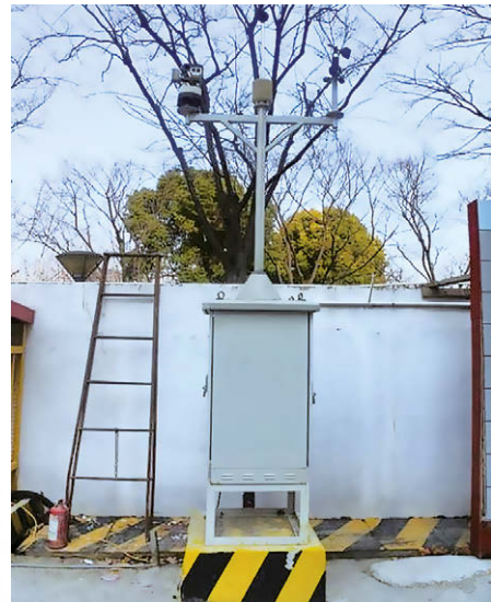
在建築地盤安裝分貝測量儀，監控噪音水平，每日進行數次隨機檢查，不定時記錄度數。
