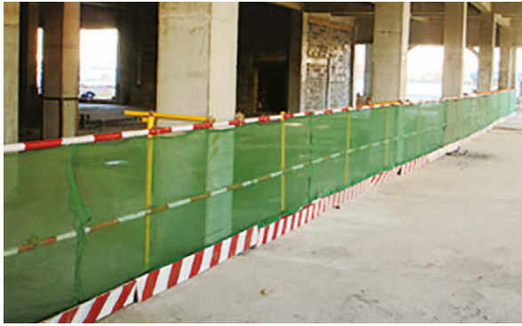
樓梯、陽臺等臨邊設置穩固欄桿等防護設施以保護工人施工安全實例。
