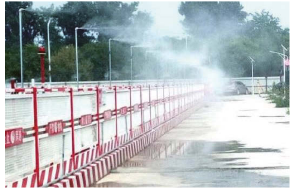
使用灑水系統以防止塵埃飛揚的實例
