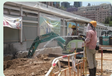
Water Sprinkling Techniques 灑水技術
