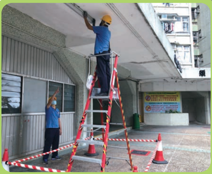
Use of Ladder Platform 使用梯台
