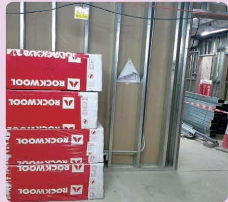
Rockwool is Utilised Onsite to Control Noise 地盤使用岩綿控制噪音
