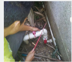
供水設備日常維護
