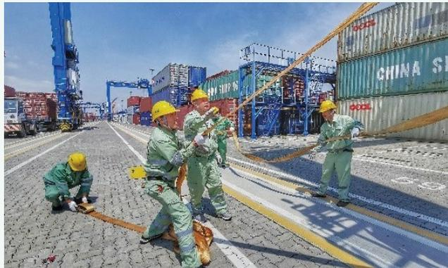
我們有既定流程應對颱風。颱風抵達前，碼頭作業人員會停止手上的工作，對現場的設備進行加固及綁定，將碼頭上的集裝箱和超高箱吊架移開，並檢查重點區域的防漏排水措施及雨水泵房運轉情況。颱風抵達後，相關部門會密切留意颱風移動路徑。颱風警報解除後，安全部門將檢查颱風過後的安全隱患，其他部門將加強與船公司、引航站、控制中心的溝通，制定運營恢復方案。
