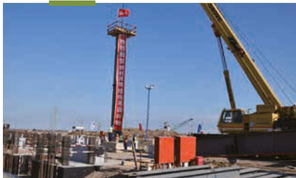
■ 中信建設伊拉克米桑電廠項目燃機房鋼結構開始吊裝
