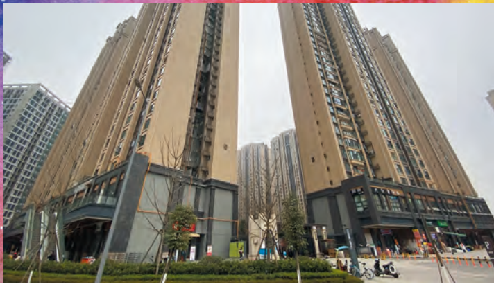
Chengdu Chenghua Aoyuan Plaza 成都成華奧園廣場
