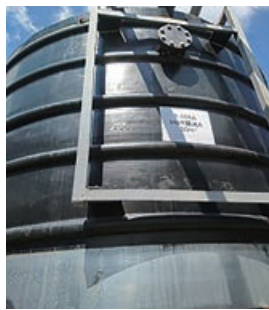
生物濾膜槽(MBR)
