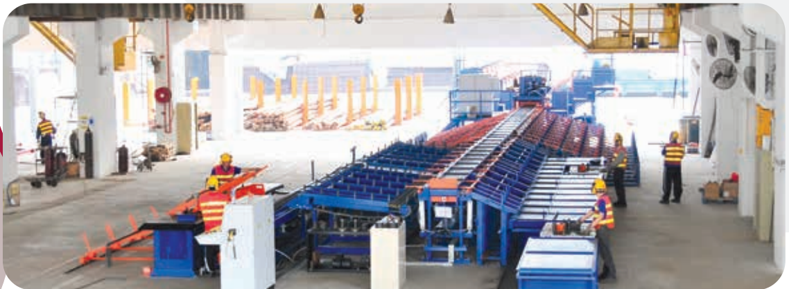
香港大埔之鋼筋自動化加工工場
