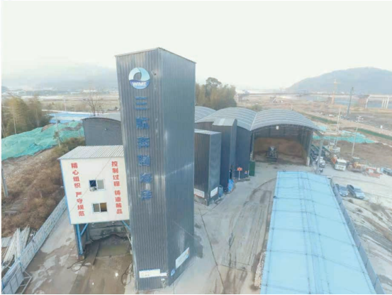
攪拌站全封閉
