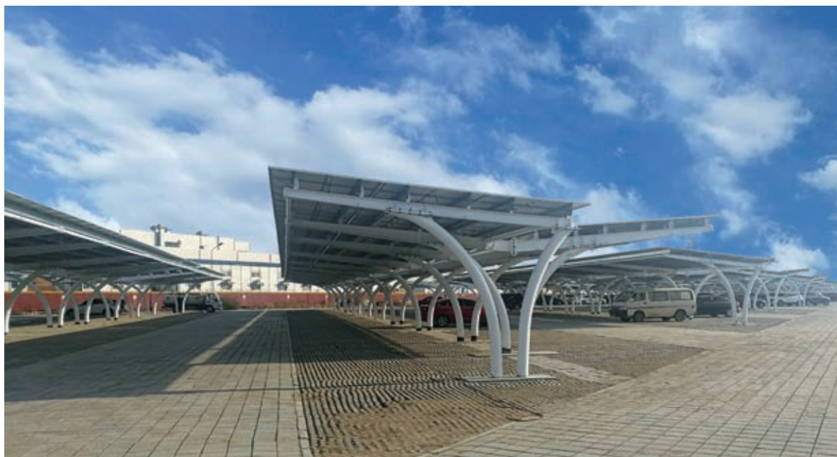
北京奔馳光伏發電設施
