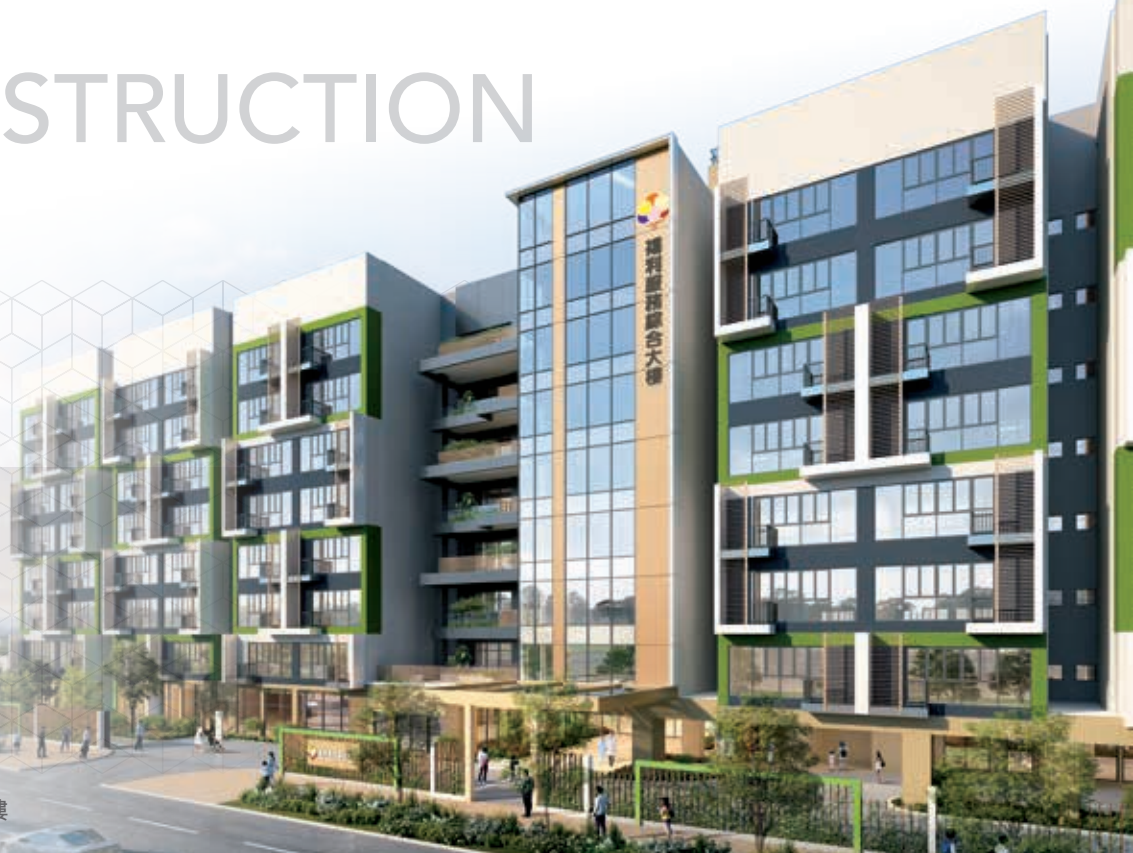
古洞北特建福利服務綜合大樓
