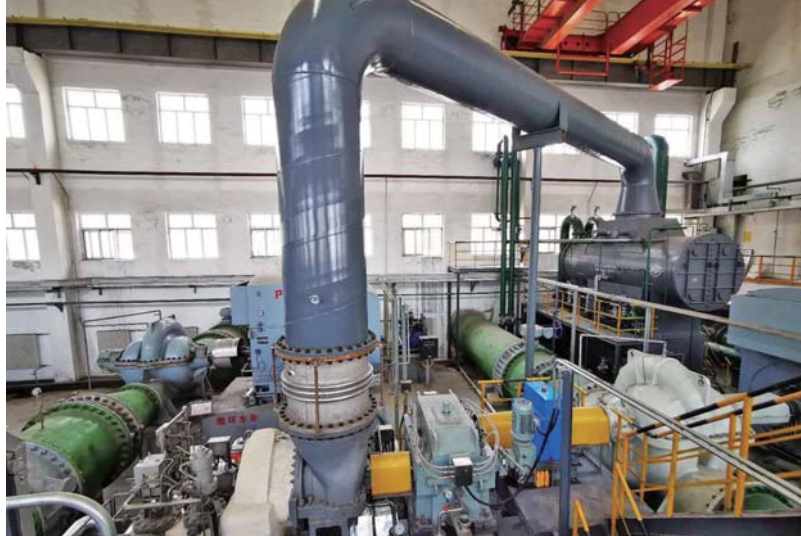
● 華鶴煤化工循環水泵汽電雙拖改造項目
