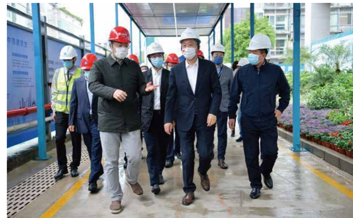
巡视施工项目复工复产情况
