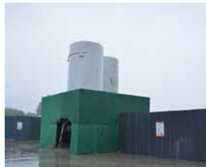
封闭式预拌砂浆罐
