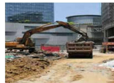
建筑渣土外运
