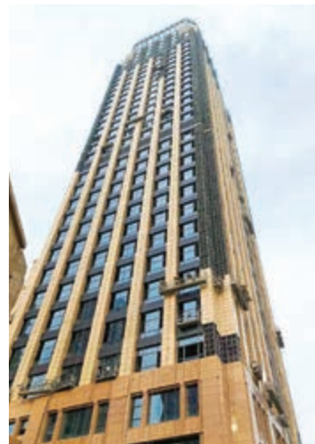
寫字樓大樓 — 上蓋建築工程現正進行中
