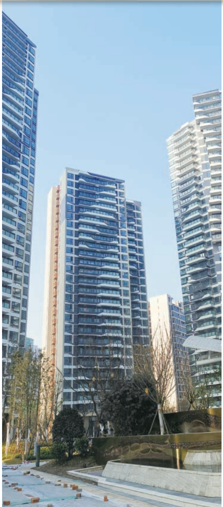
富豪國際新都薈富豪公館(第二期)之住宅大樓 — 上蓋建築工程及裝修工程現正進行中
