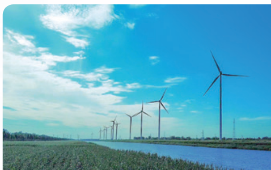
山東省濱州市風力發電站
