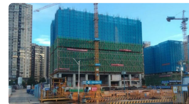
長沙雲頂都匯圍蔽作業、硬化道路、濕法作業
