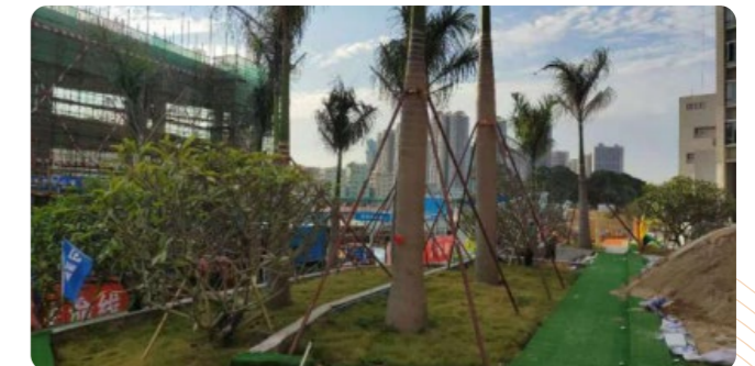
平湖佳兆業廣場綠化工程
