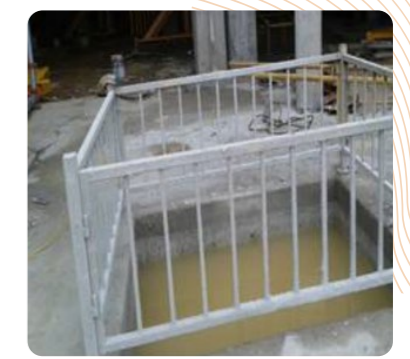
長沙雲頂梅溪湖工程設有沉澱池
