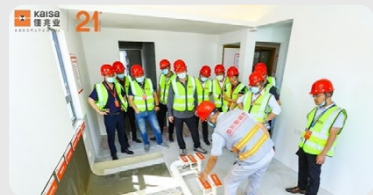
員工觀摩施工中的裝配式住宅項目
