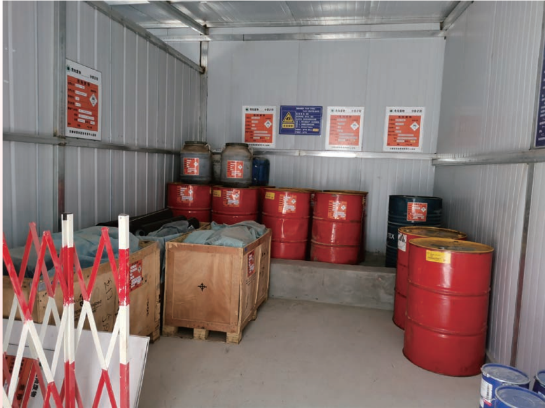
大唐新能源甘肅分公司廢油暫存庫
