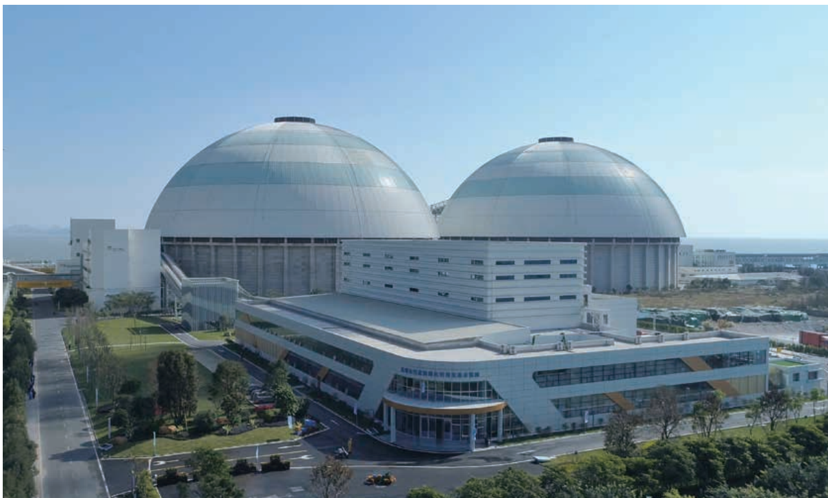
海丰电厂污泥耦合掺烧项目
