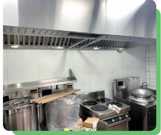
組合牆板裝配完成後
