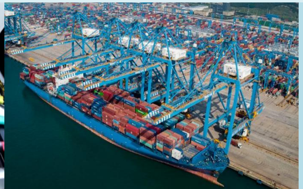
自動化集裝箱碼頭裝卸作業中
