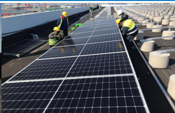
冷庫庫頂安裝光伏發電設施
