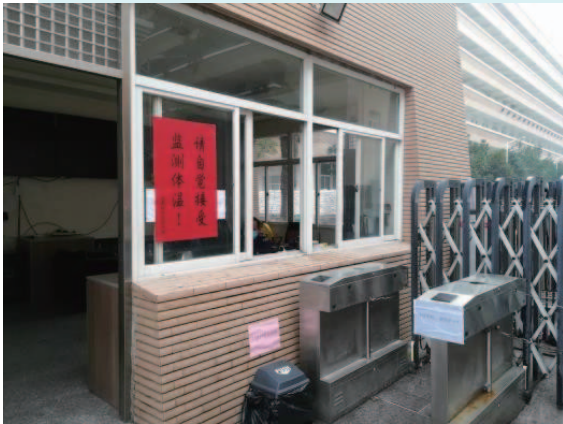
廠房設立體溫檢測站為員工每日檢查體溫
