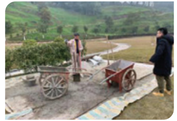
墓區施工安全指導
