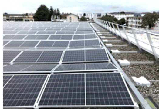
本集團在瑞士穆爾滕 (Murten) 的廠房屋頂上安裝了 900 平方米的光伏電池，每年估計可發電 123 兆瓦時。
