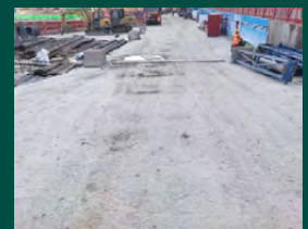
在工地內硬化路面並以鋼片覆蓋泥路，以減少塵土產生
