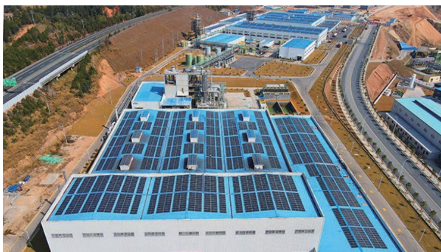
紫金新能源公司建設的首座3.4MW分佈式光伏發電項目投入使用
