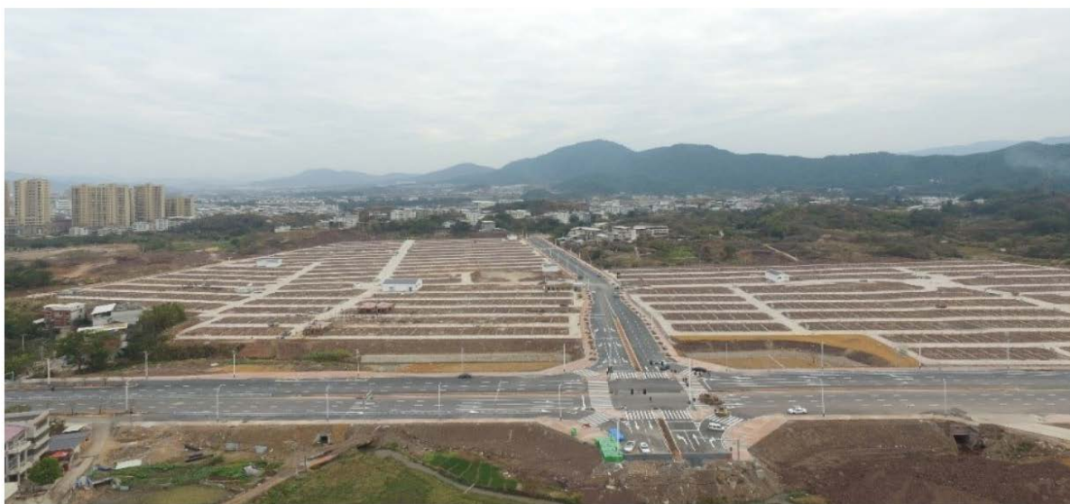
逕美村移民安置地項目實景
