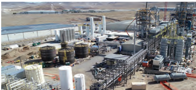
攝於2019年11月。Fulcrum Bioenergy廠房施工進度理想，預料可於2021年竣工。
