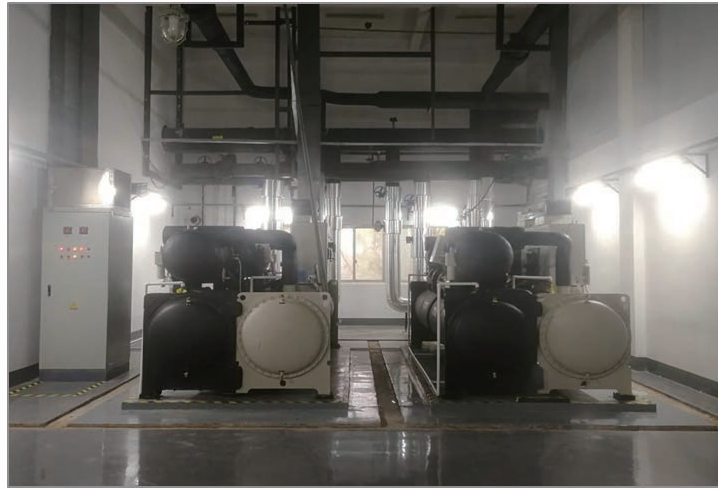
圖1 中車時代電氣製造中心溴化鋰機組淘汰升級為磁懸浮螺桿機組
