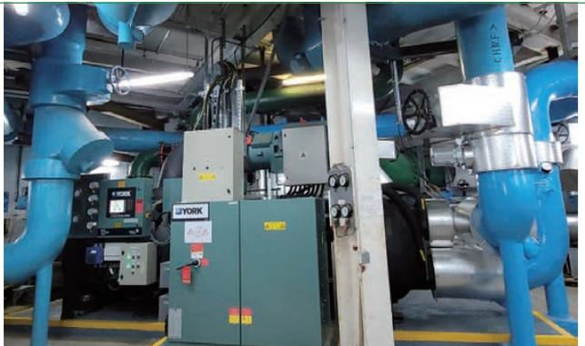
傳統冷水機組常以手動方式控制，可經由重新校驗作出優化。海港城實行了重新校驗，透過優化港威大廈二期及海運大廈新擴建大樓的冷水機組運作以減少能耗。
