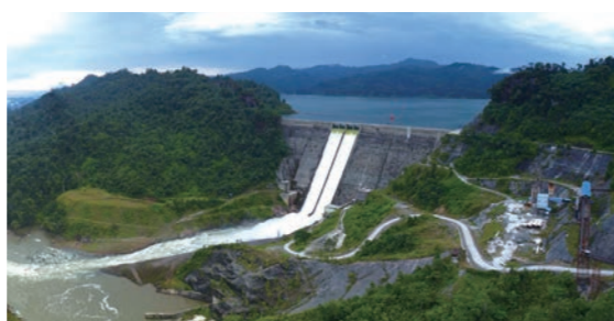
◆ 马来西亚沐若水电站项目
