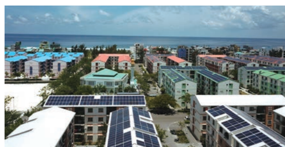
◆ 马尔代夫 1.5 兆瓦光伏电站项目
