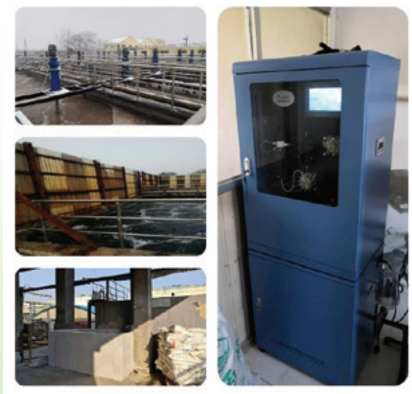
污水處理站與管道的整改工程及新增的設備
