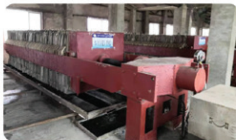
徐州皮廠於上半年完成九台污泥壓濾機器的維修工程
