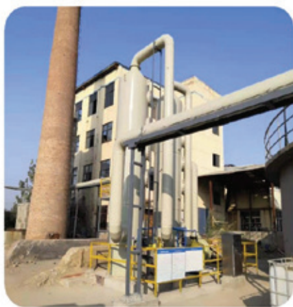
新增廢氣收集處理設備及完成污水處理站加蓋密閉工程
