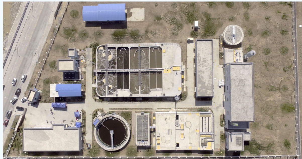
堆龍德慶工業園區污水處理廠俯瞰圖
