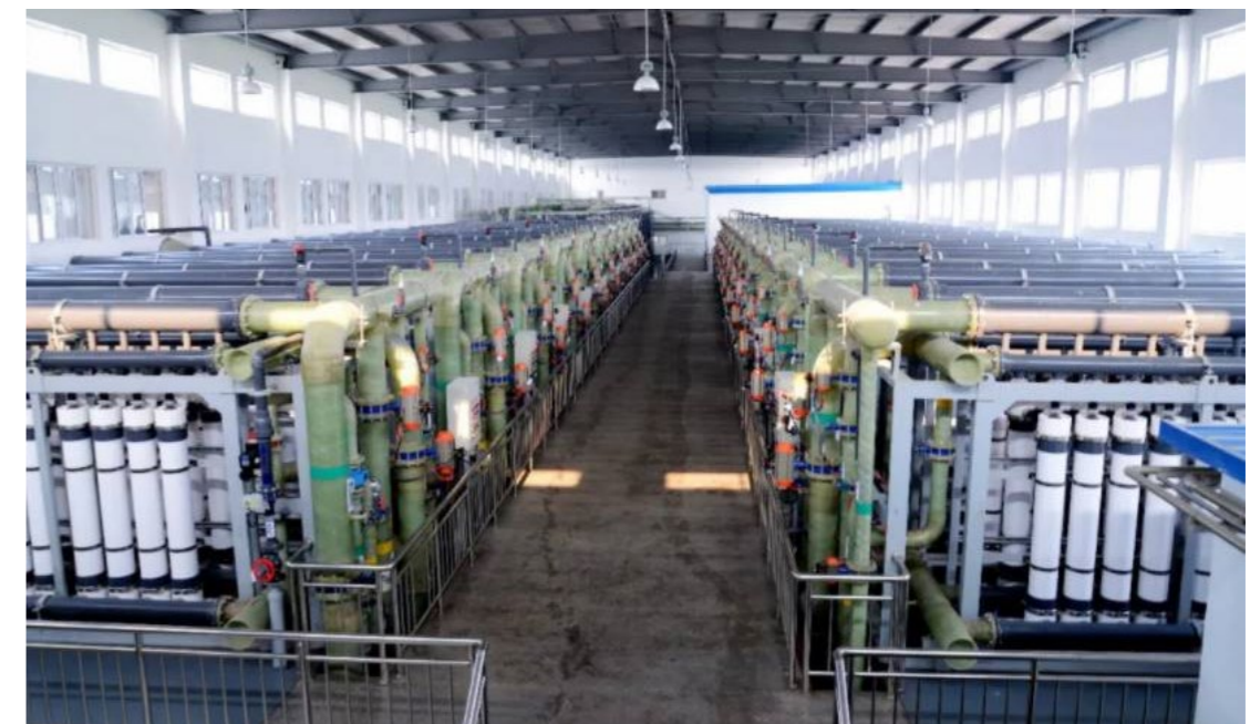
濰坊市壽光濱海經濟開發區再生水回用工程項目
