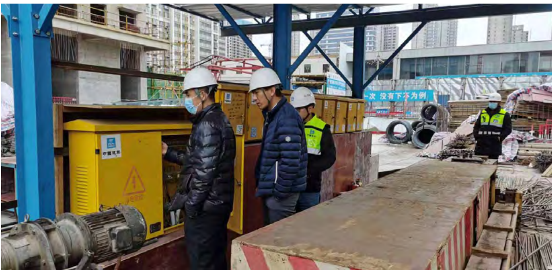
首創置業首新事業部安全生產檢查現場
