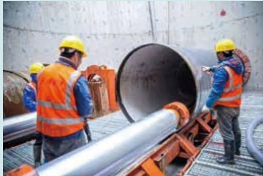
台州市南部灣區引水工程原水管線全面開展主體建設
