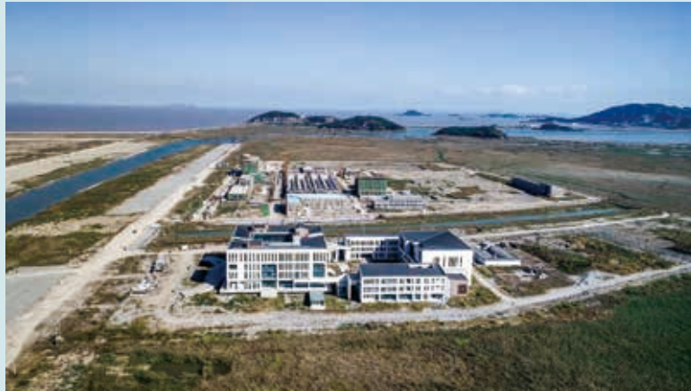
台州市引水工程東部水廠土建主體結構完工
