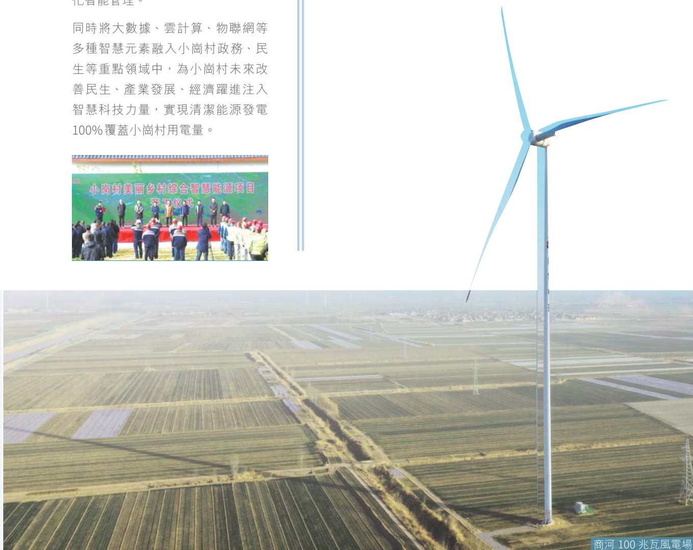
商河 100 兆瓦風電場
