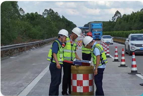
路面改造工程的安全生產檢查
