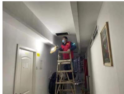
項目工程員工維修更換電路
