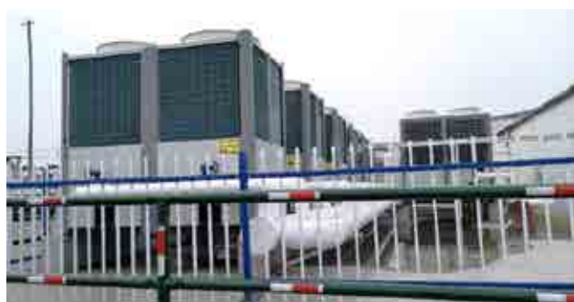
【內蒙古太平安裝空氣能熱泵】
