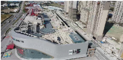
江蘇興化吾悅廣場太陽能光伏電站
