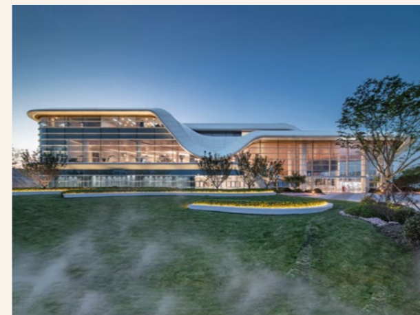
青島西海岸創新科技城展示中心建築光伏一體化項目，光伏安裝面積300平方米，裝機容量40千瓦，年發電量5萬千瓦時
