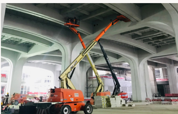
参建雄安高铁站
