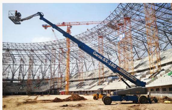
参建沈阳奥体中心
