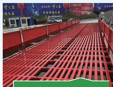
工地出口設置洗車槽
