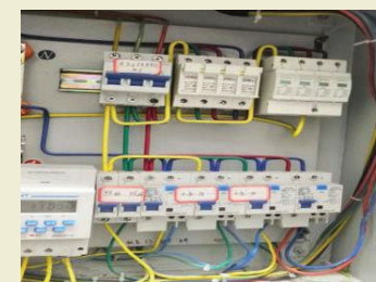
LED 燈時控、聲光控、雷達感應系統改造
