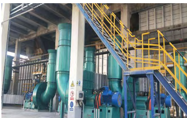
第四代篦冷機節能升級改造
