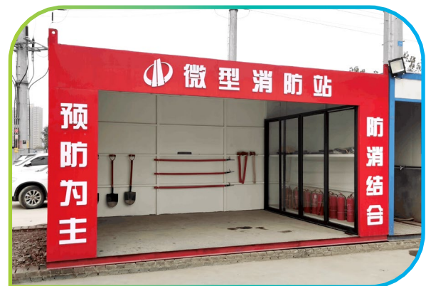
施工現場採用可重複利用的微型消防站
