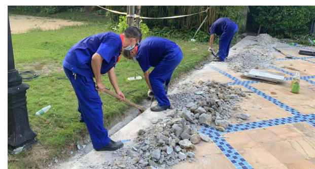
地面維修 Ground maintenance
